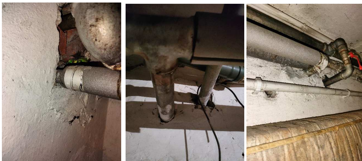
Rysunek 2 Przykłady starszych instalacji niezabezpieczonych lub zabezpieczonych częściowo. Materiały własne
